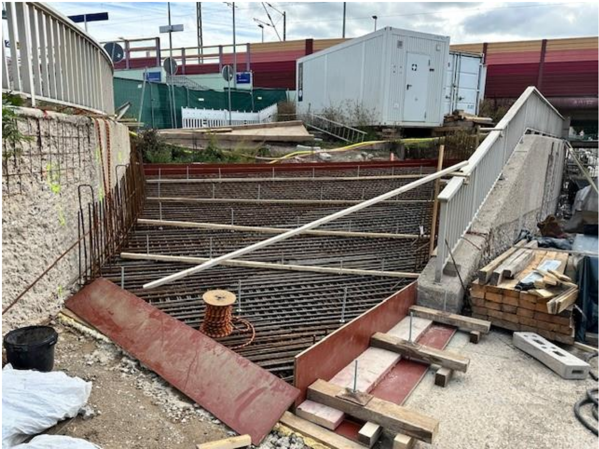
Foto: Herstellung Schlepp-Platte Bahnzugang
