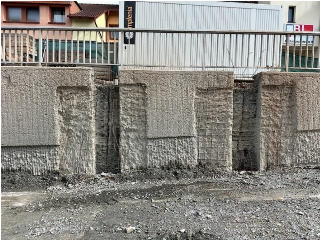
Foto: Vorbereitungsarbeiten für den Einbau zusätzlicher Bewehrung und UHFB im Bereich der Rissfugen
